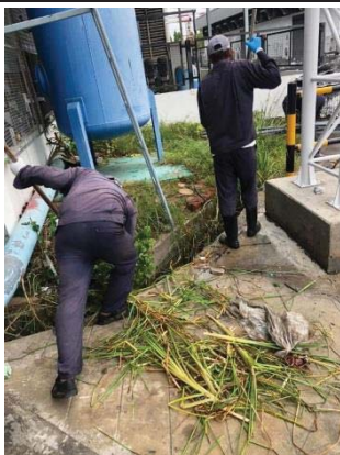
ภาพที่ 23 เจ้าหน้าที่ทำความสะอาดระบบระบายน้ำฝน
